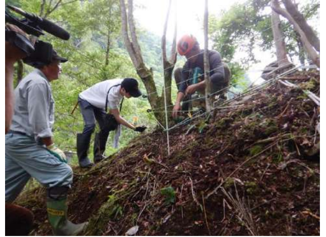
電気柵を設置する様子 (No.1 地点)
